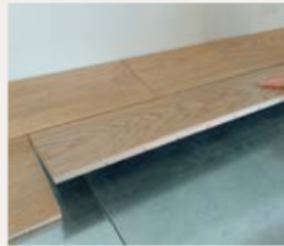
Pose sur faux-plancher
