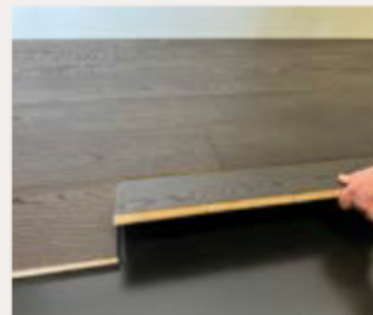
Pose sur sous-couche magnétique
