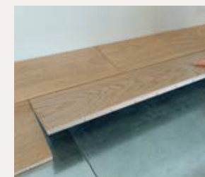
Pose sur faux-plancher
